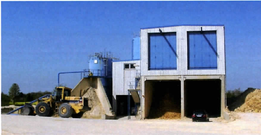
Abb.1: Kammerfilterpressenanlage zum Tonmineral- und Wasserrecycling
